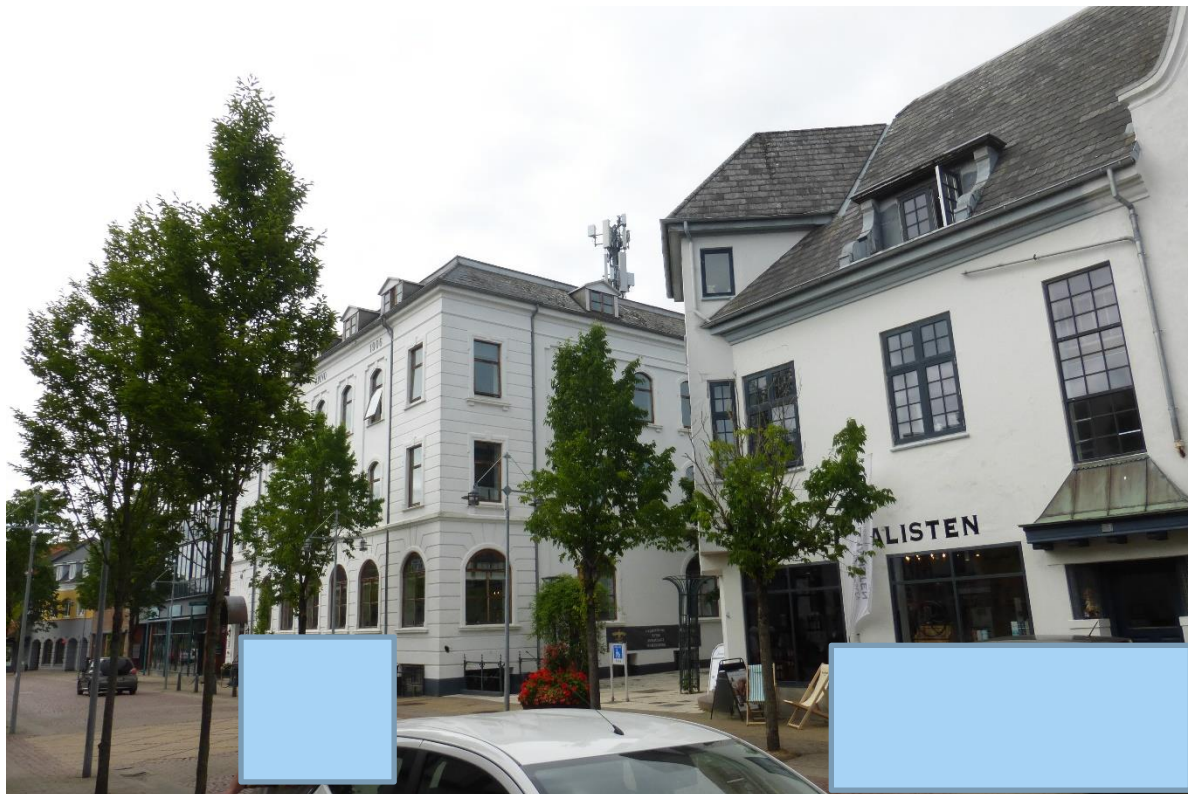
Antenner på adresse Bredgade 17 set fra sydøst
