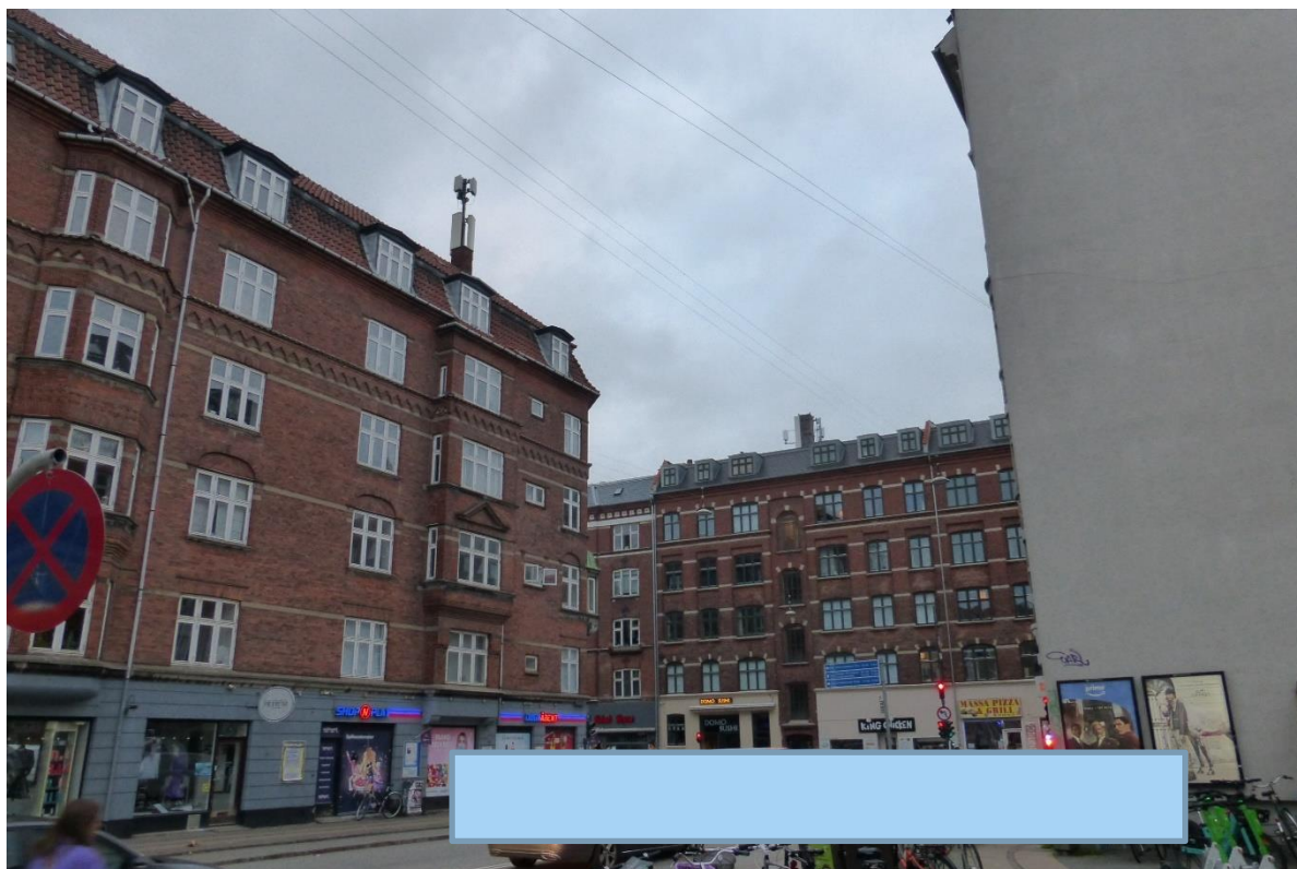
Foto af bygning taget fra sydvest
