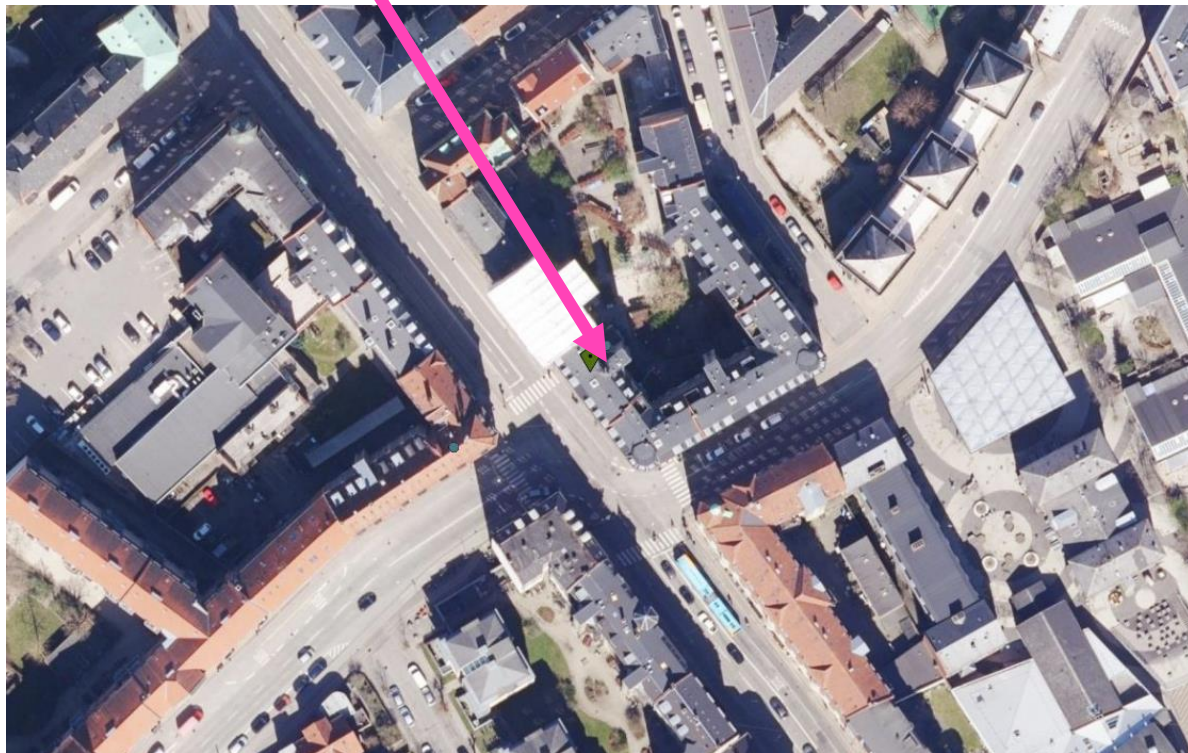
Planfoto – antenner på taget pegende ud i horisonten 120 grader forskudt på bygningen
