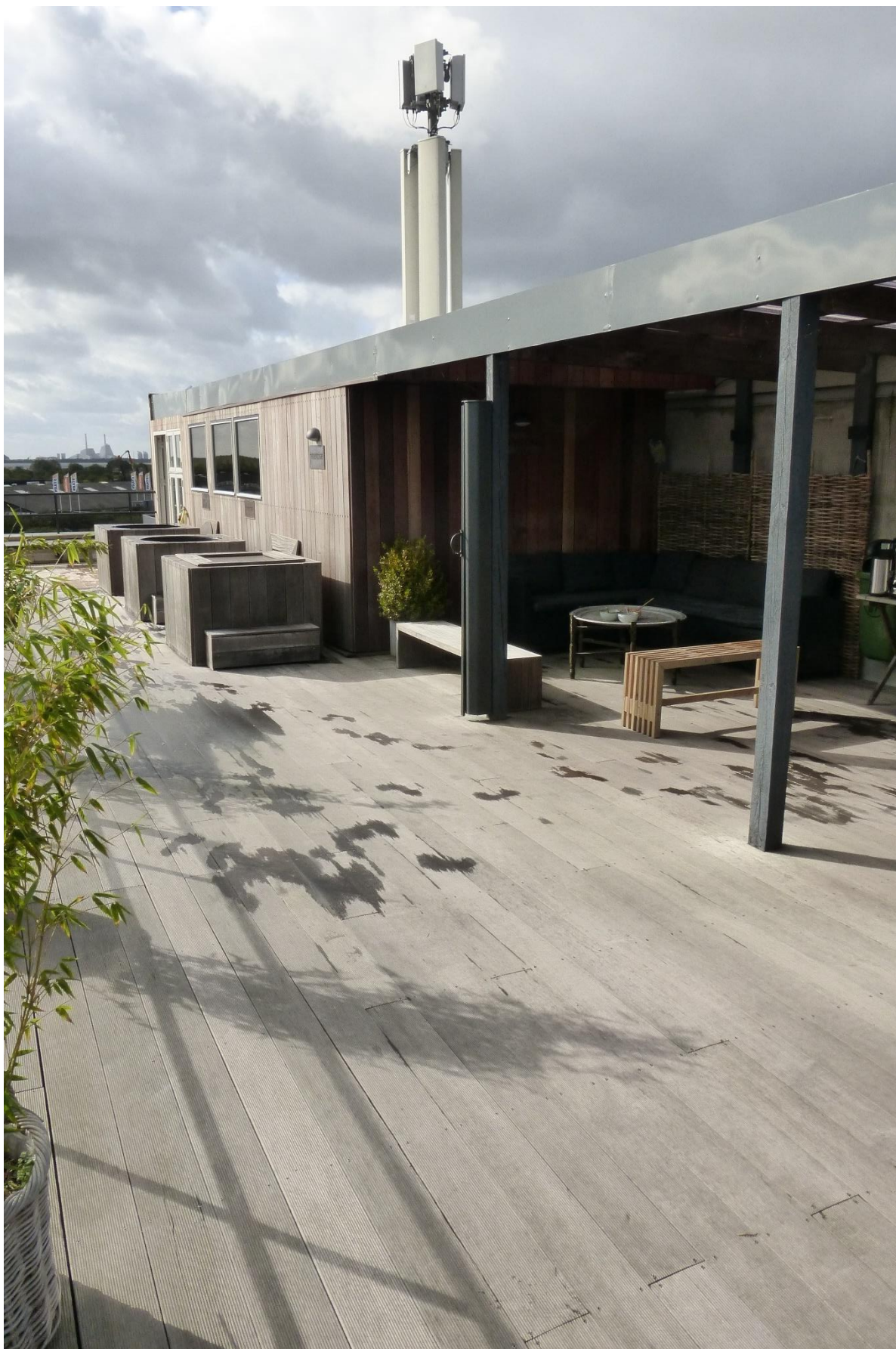
Foto af tagterrasse med bærerør
