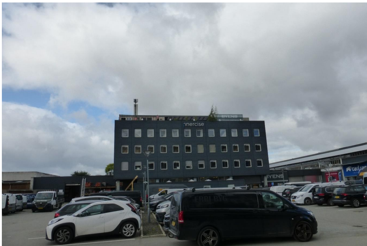
Foto af bygning taget fra sydøst
