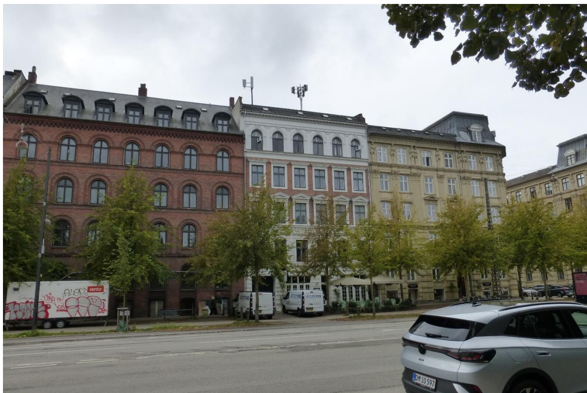
Antennner placeret på taget
