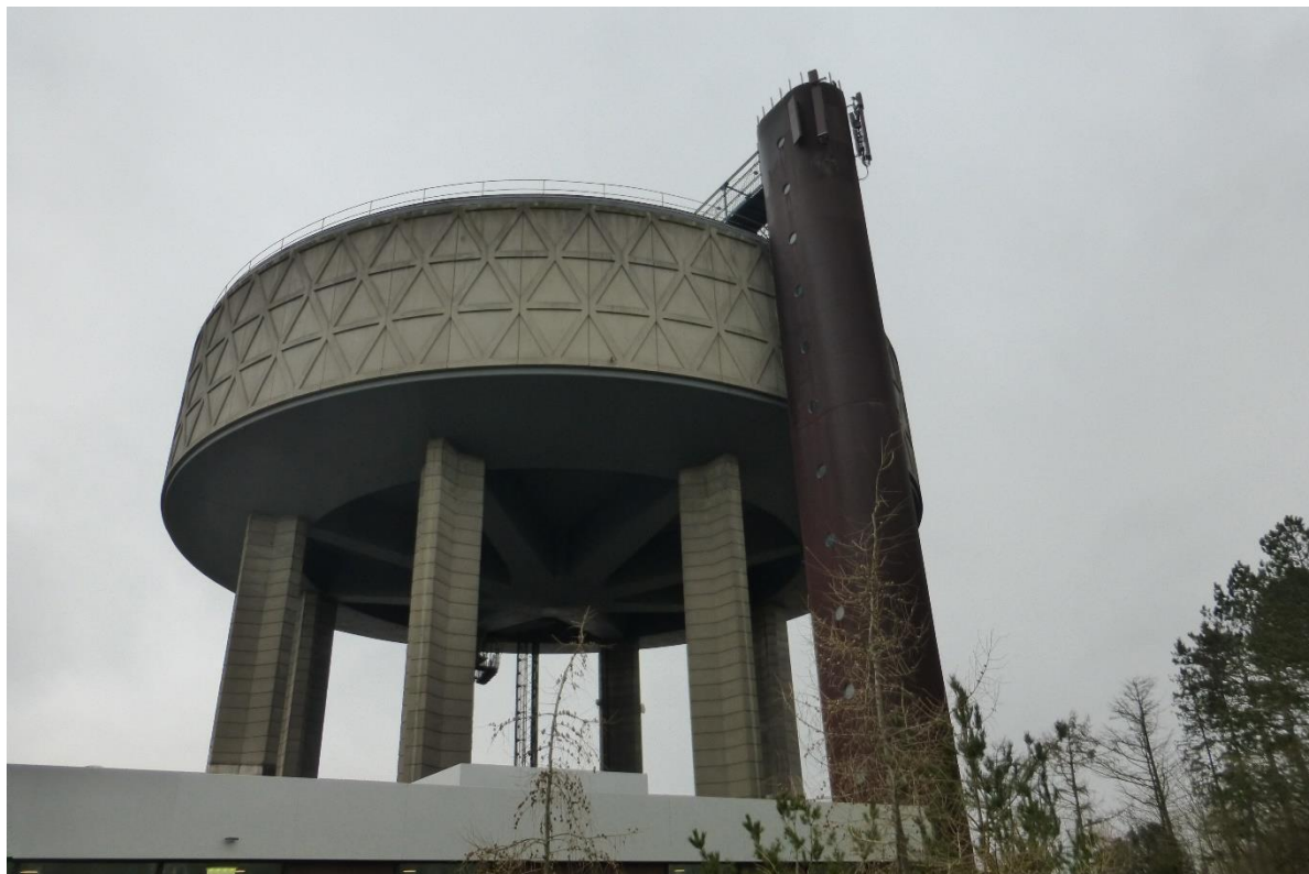
Antenner på vandtårn set fra sydøst
